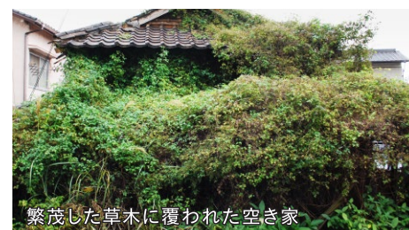
繁茂した草木に覆われた空き家
